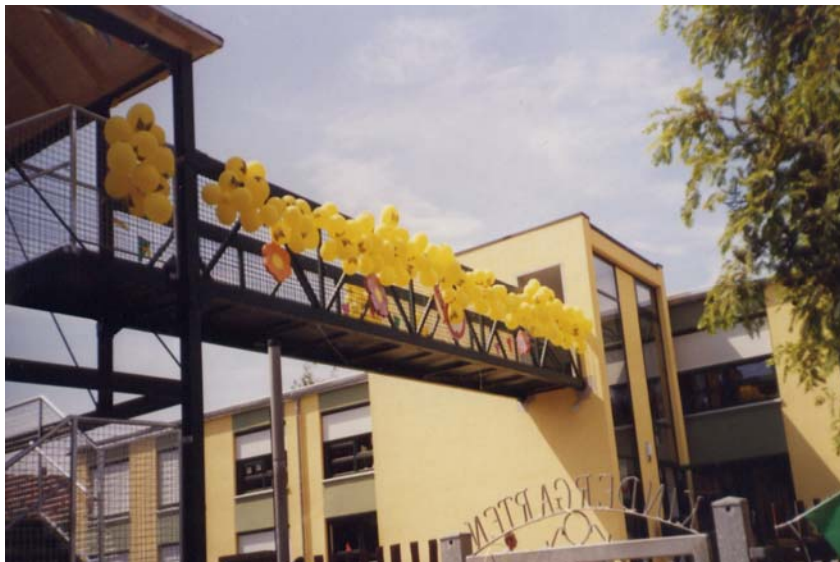
Nützlich und trotzdem eine Augenweide - unsere Brücke im Juli 2004
